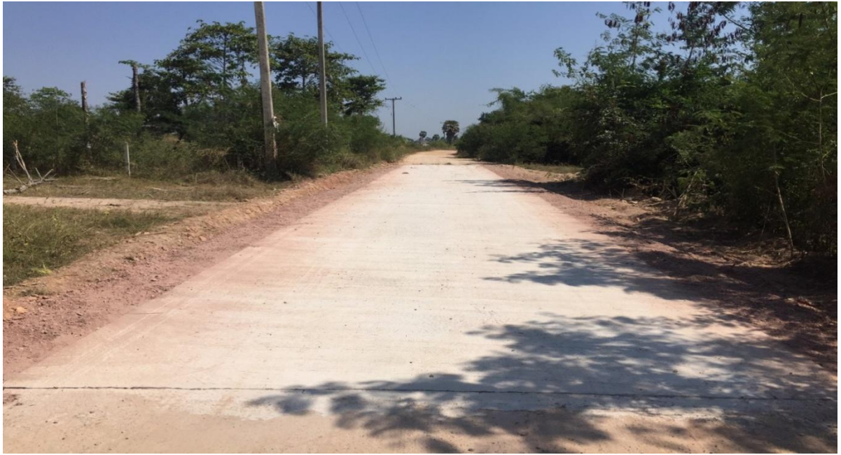
โครงการงานก่อสร้างถนนคอนกรีตเสริมเหล็ก ซอยหญ้าคา หมู่ ๓ บ้านหนองนกน้อย
